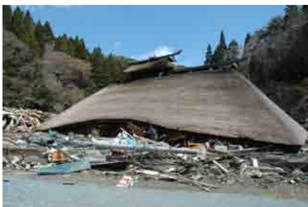
4月24日集会所と電柱が撤去されたあと。撮影・葉山茂
